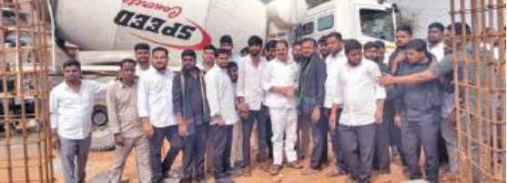
కళాశాల భవన నిర్మాణ పనులను పరిశీలిస్తున్న ఎమ్మెల్యే శంకర్
